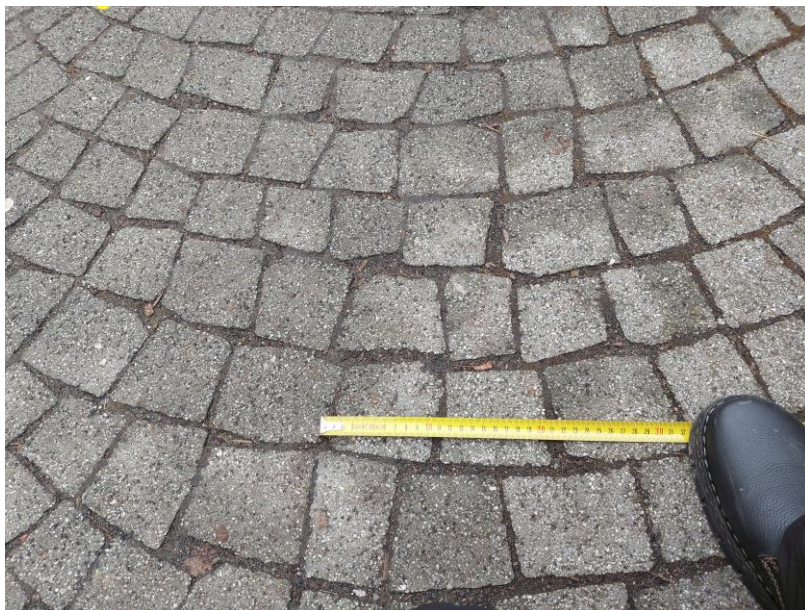
Foto 1 – příklad provedení stávajícího chodníku z betonových kostek 60 mm do vlaštovky, viz stávající chodník pod památnou lípou.
