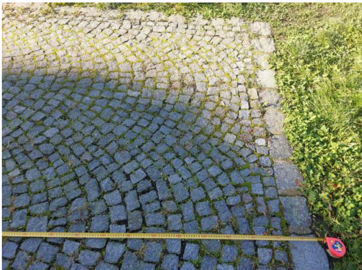
Foto 3 – Příklad stávajícího chodníku z žulových kostek 4/6 do vlaštovky, nové chodníky u SO 02 – FARNÍ ZAHRADY, VRCHNÍ ČÁST budou provedeny stejným způsobem.
