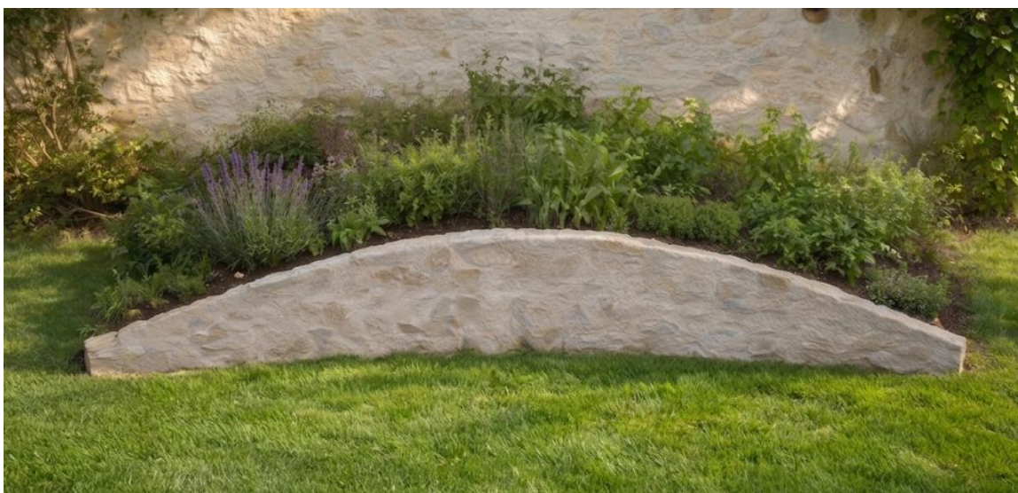
Foto 2 – příklad provedení podlouhlých obvodových stěn vyvýšených záhonů z kamenné zídky na cementovou maltu.
